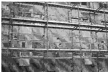
Bild 2 Murning från ett nedsänkt arbetsplan innanför de inre spirorna.
